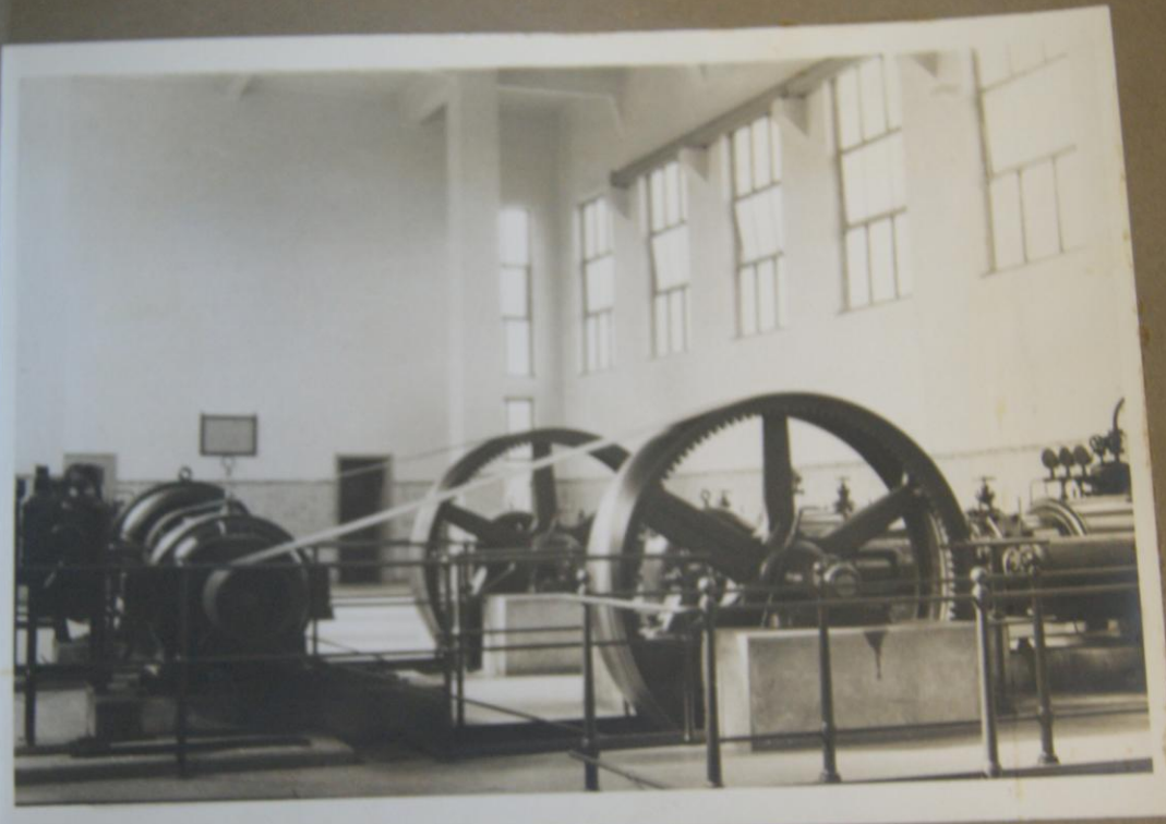
Salle des machines
