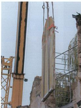
Dépose vue depuis l'usine MIKO
