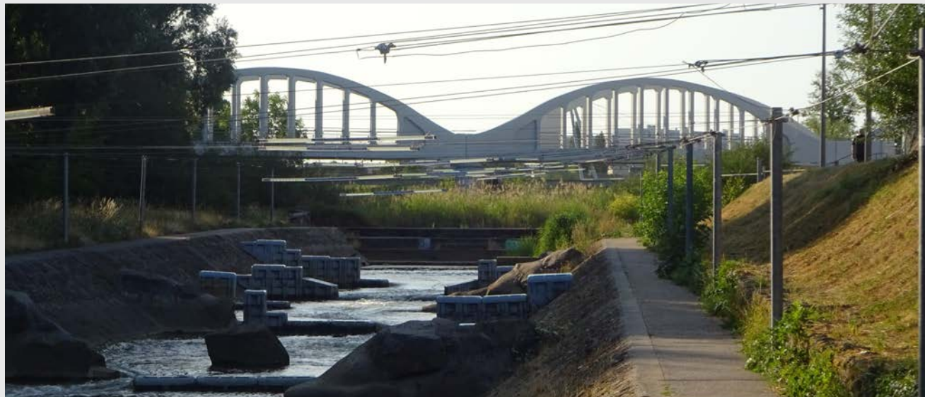
Pont bow-string pour la voie ferrée, conservé pour les promeneurs
