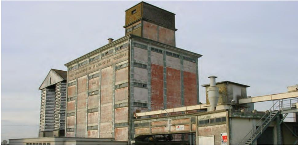
Fig. 10 - Saint-Amand de Vendôme (41) : un des premiers silos réalisés par la Franciade, qui comprend les trois modes de stockage (vrac sur plancher, sacs et cellules) (cliché de Nicolas Loriette).
