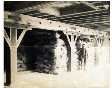
Fig. 6 - Un étage de stockage pour le sucre : planchers en biais, poutres en chêne ou en orme selon l'étage.
