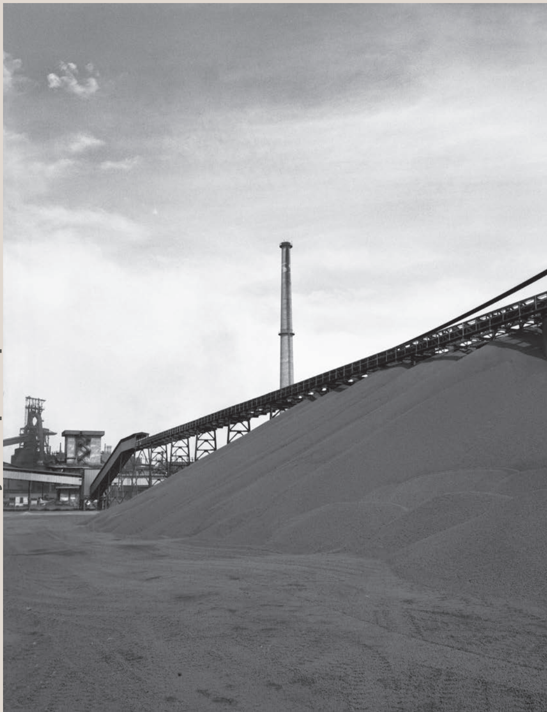
Patio de Pellet. Siderúrgica Lázaro Cárdenas "Las Truchas". Estado de Michoacán, 1989.
