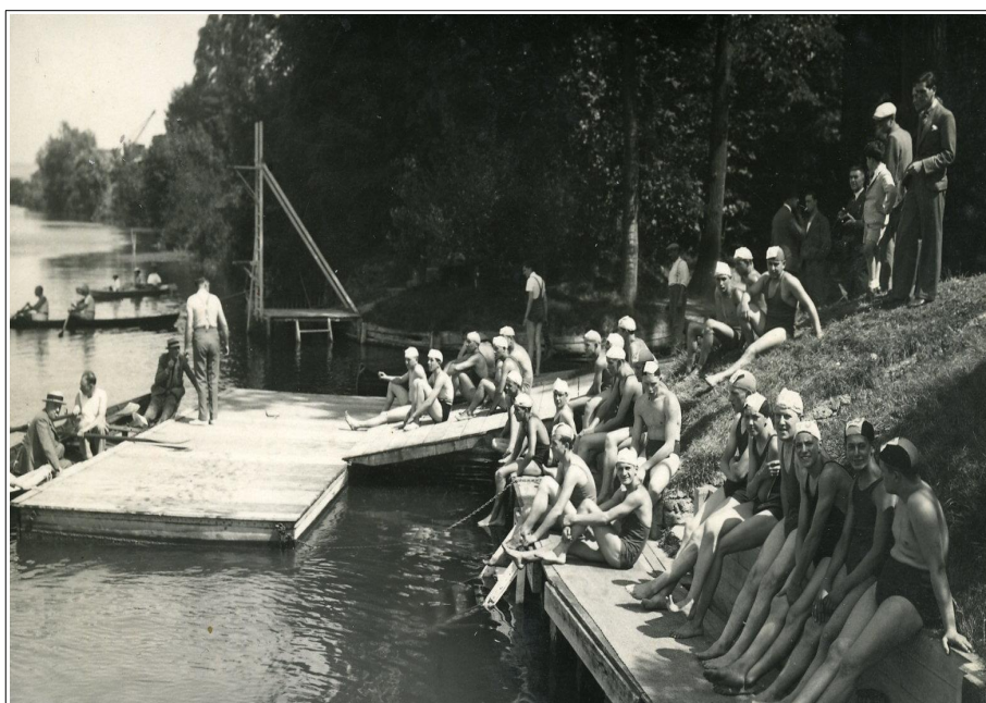
Bassin nautique des cheminots (La Villa d'Aÿ, 1960)
