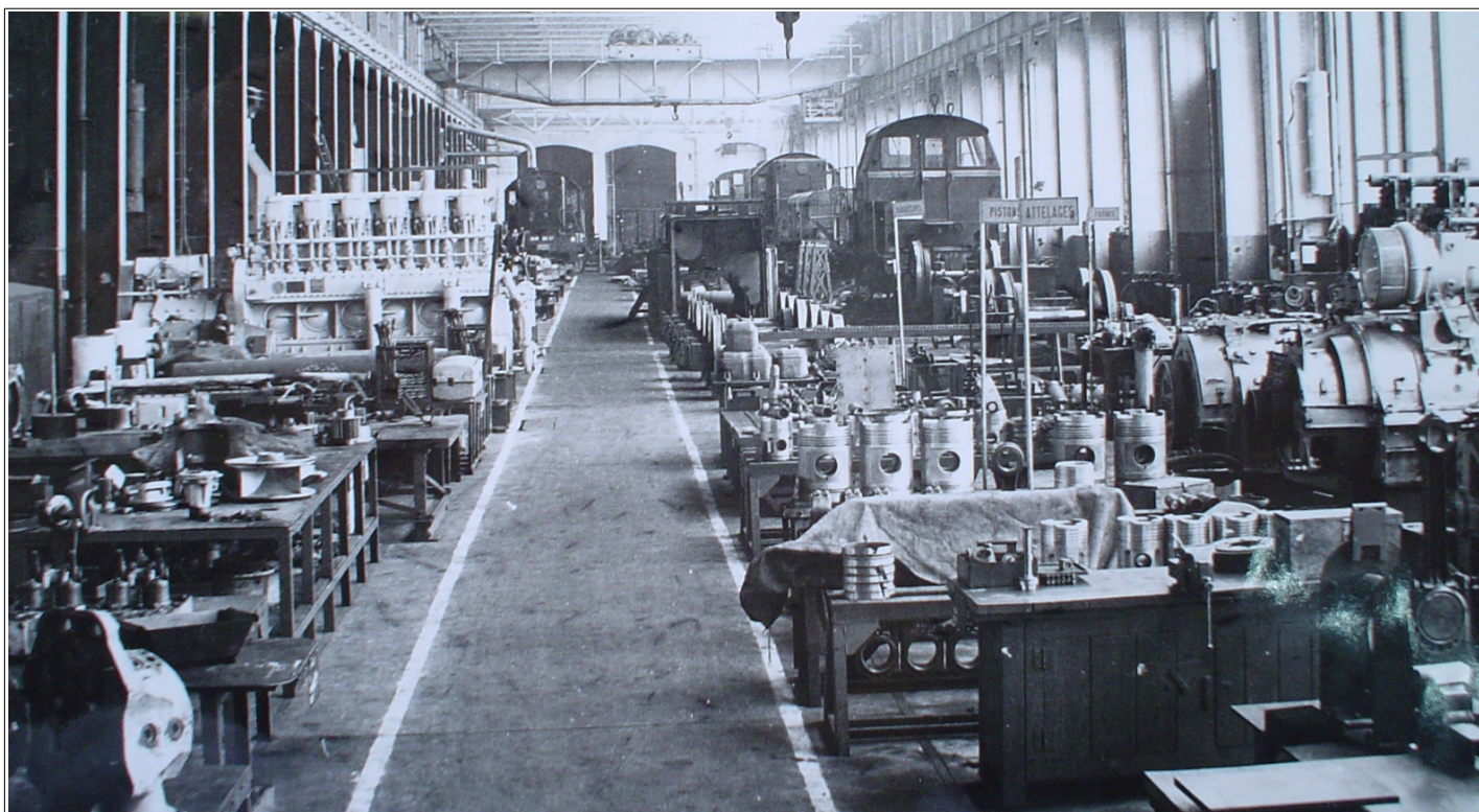
Hall du Montage au début des révisions de locomotives-diesel (1952-53)
