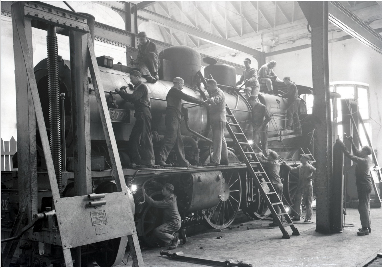
Équipe d'apprentis de 3 e année chargés de la révision d'une locomotive sous la direction d'un maître-ouvrier (1928)
