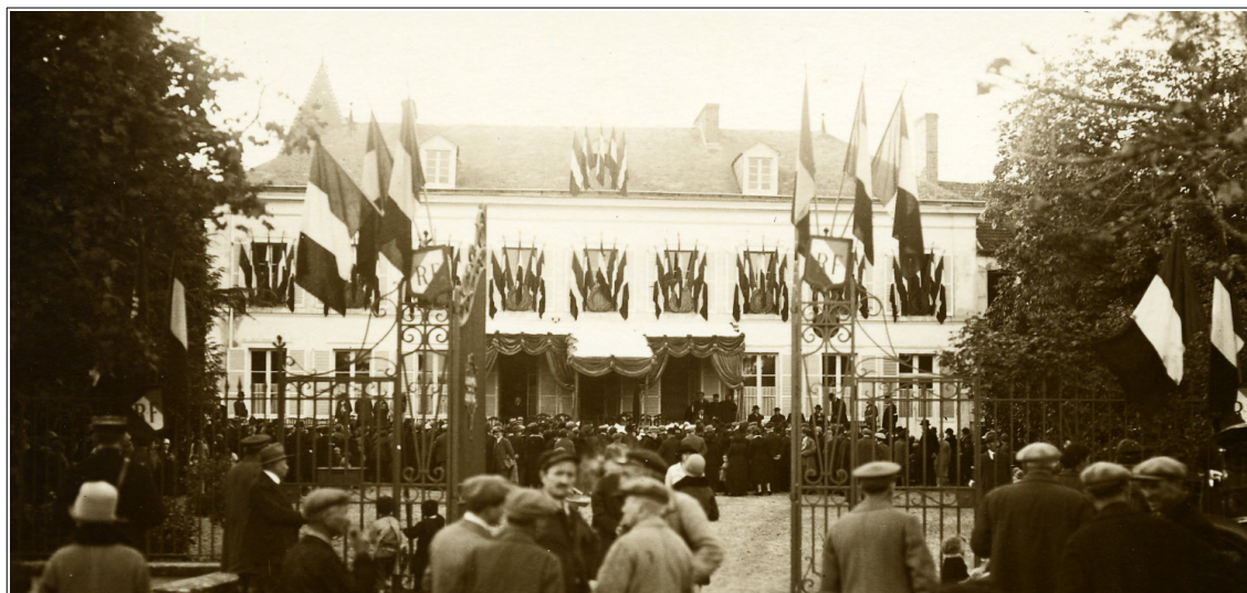
Inauguration du Refuge de La Foulerie
