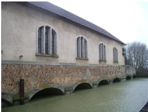
Le bassin aval
