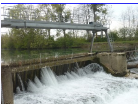
Barrage d'alimentation du canal Vitry-le-François
